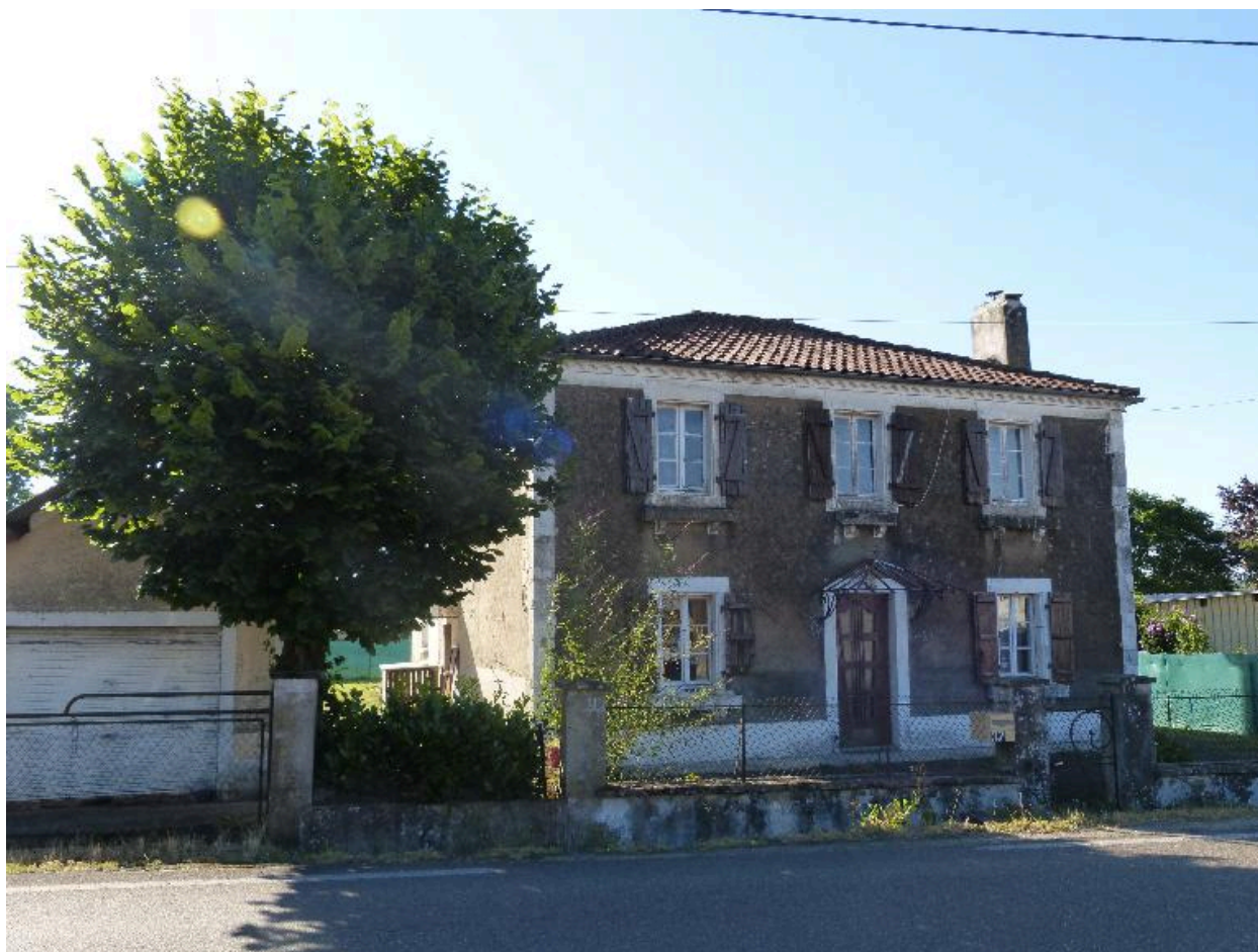
Vue de la façade sur rue.
