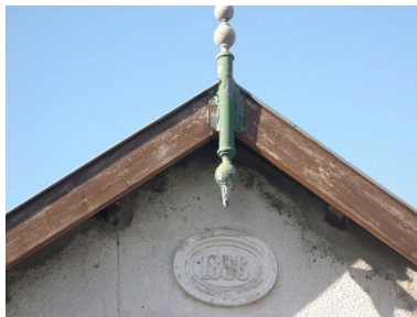
Détail de la façade du n° 26. Phot. Christine Redien-Lairé IVR54_20061700326NUCA
