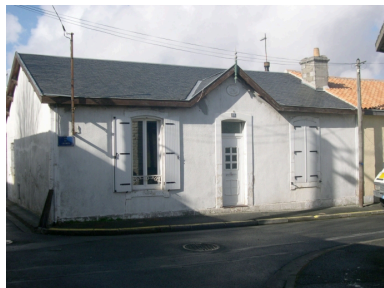
Façade du n° 28. Phot. Christine Redien-Lairé IVR54_20061700325NUCA
