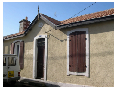
Façade du n° 26. Phot. Christine Redien-Lairé IVR54_20061700327NUCA
