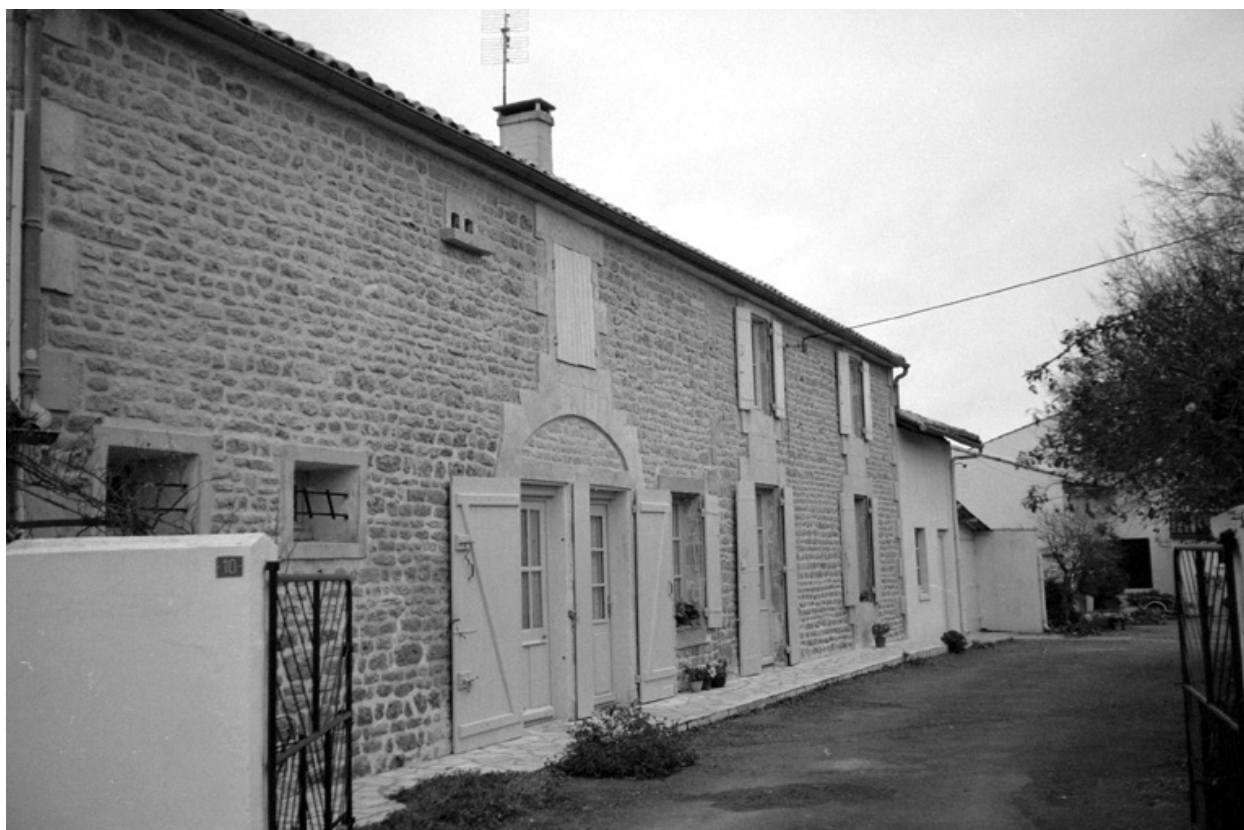
Une vue de l'ancienne ferme, depuis l'ouest.
