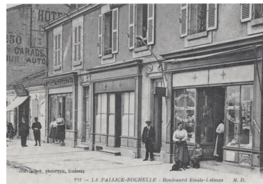
Vue ancienne (carte postale). Phot. Yann Cussey IVR54_20071704643NUCA
