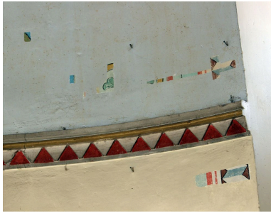
Détail de la partie sud du mur, de la corniche et du cul-de- four, avec témoins de sondages. Phot. Jean-Philippe Maisonnave IVR72_20184002124NUC2A
