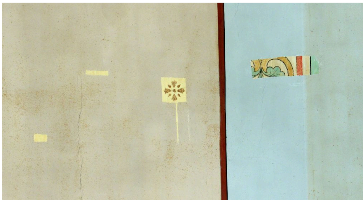
Témoins de sondages sur la voûte (entre la travée droite de chœur et le cul-de-four).
