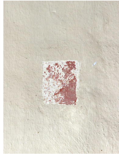
Témoins de sondages sur le mur en hémicycle. Phot. Jean-Philippe Maisonnave IVR72_20184002127NUC2A
