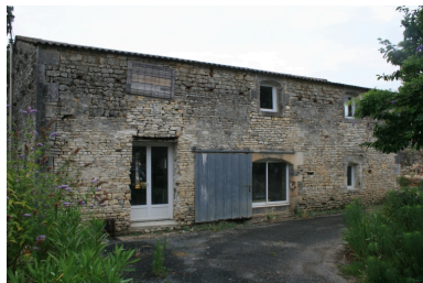
La dépendance, depuis le sud-ouest. Phot. Pierrick Barreau IVR54_20131712739NUCA
