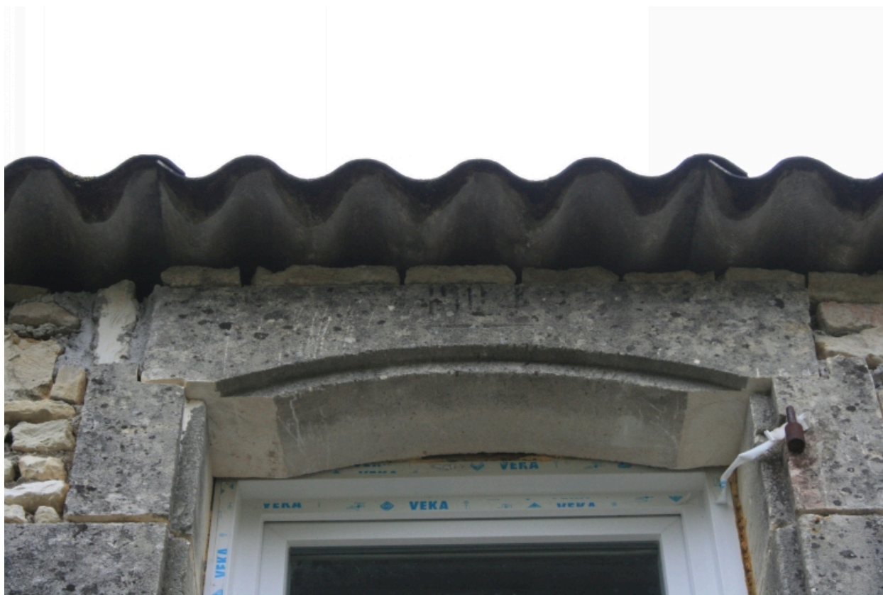
La date figurée sur une fenêtre du comble, depuis le sud-ouest.
