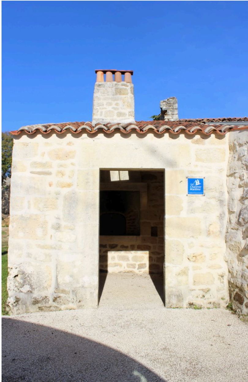
Une vue du four, depuis le sud-ouest.
