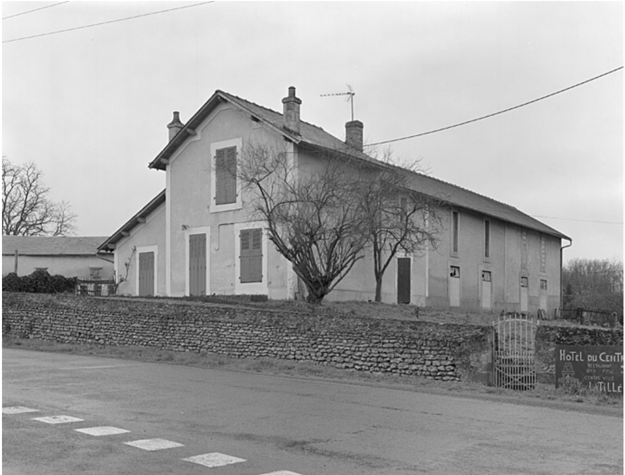
Vue générale prise du nord-est.
