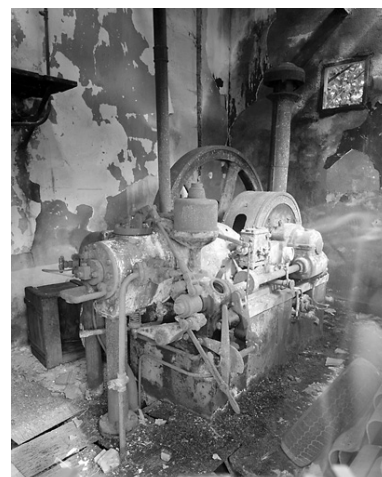
Vue de la machine à vapeur. Phot. Marc Deneyer IVR54_19958601174V
