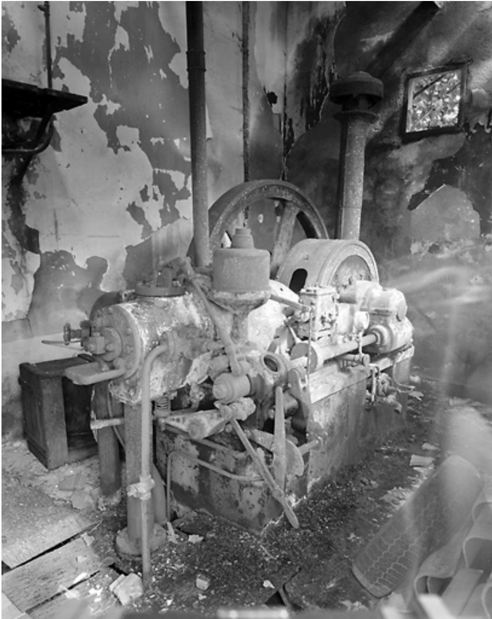
Vue de la machine à vapeur.
