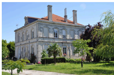
Façades postérieure et latérale nord-ouest. Phot. Jennifer Riberolle IVR72_20123302620NUCA
