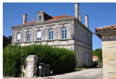
Vue d'ensemble. Phot. Jennifer Riberolle IVR72_20123302621NUCA
