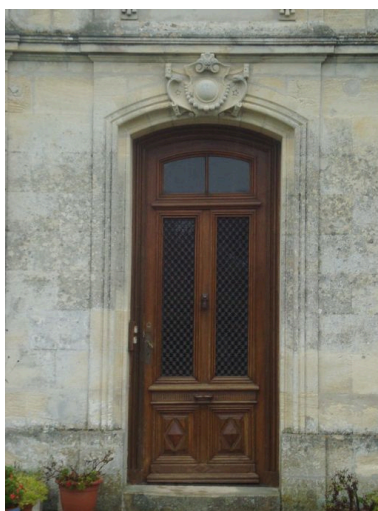
Façade principale : détail de la porte. Phot. Jennifer Riberolle IVR72_20123302858NUCA
