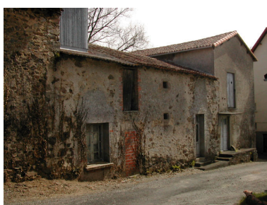
La minoterie et l'ancien logement patronal vus du nord-ouest. Phot. Pascale Moisson IVR54_20037900479NUCA
