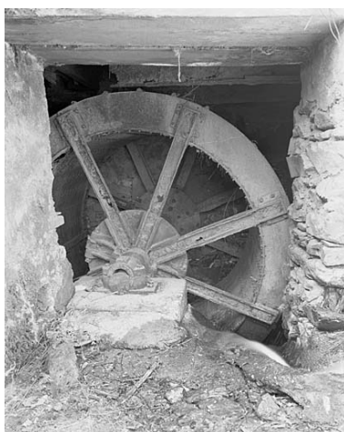
La roue métallique de dessus. Phot. Raphaël Jean IVR54_20037900449V
