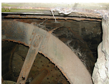
Vue de la roue métallique de dessus : les augets. Phot. Pascale Moisson IVR54_20037900477NUCA
