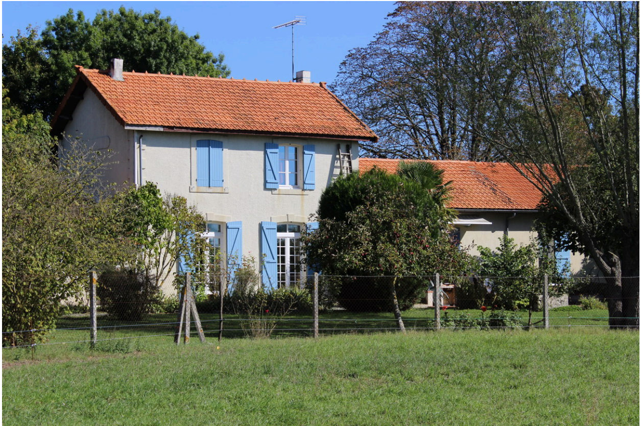
Une vue de l'ancienne gare de Saint-Loup de Saintonge, depuis le sud-ouest.
