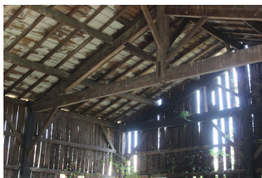
Détail de la charpente et de l'essentage de planches. Phot. Claire Steimer IVR72_20163301801NUC2A
