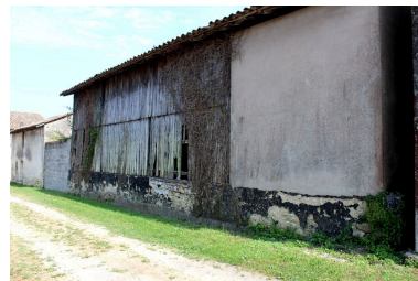
Façade postérieure. Phot. Claire Steimer IVR72_20163301806NUC2A
