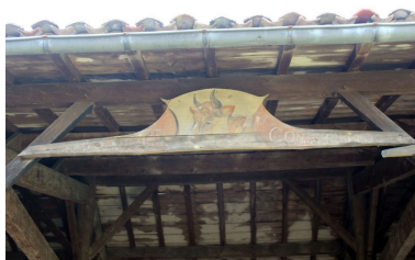
Détail de l'entrait de charpente peint. Phot. Claire Steimer IVR72_20163301800NUC2A
