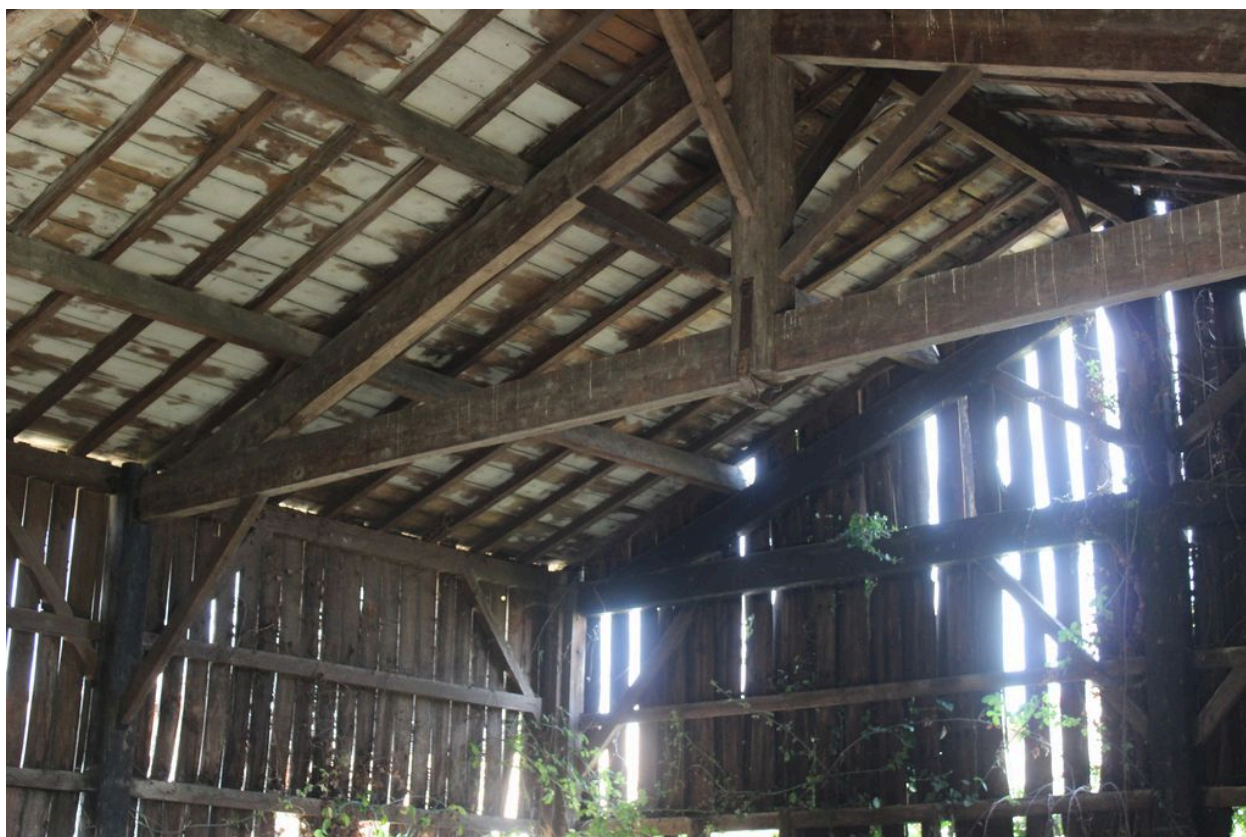
Détail de la charpente et de l'essentage de planches.
