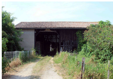
Vue d'ensemble. Phot. Claire Steimer IVR72_20163301799NUC2A
