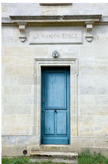
Porte d'entrée. Phot. Evelyne Perriat IVR72_20153390249NUC4A
