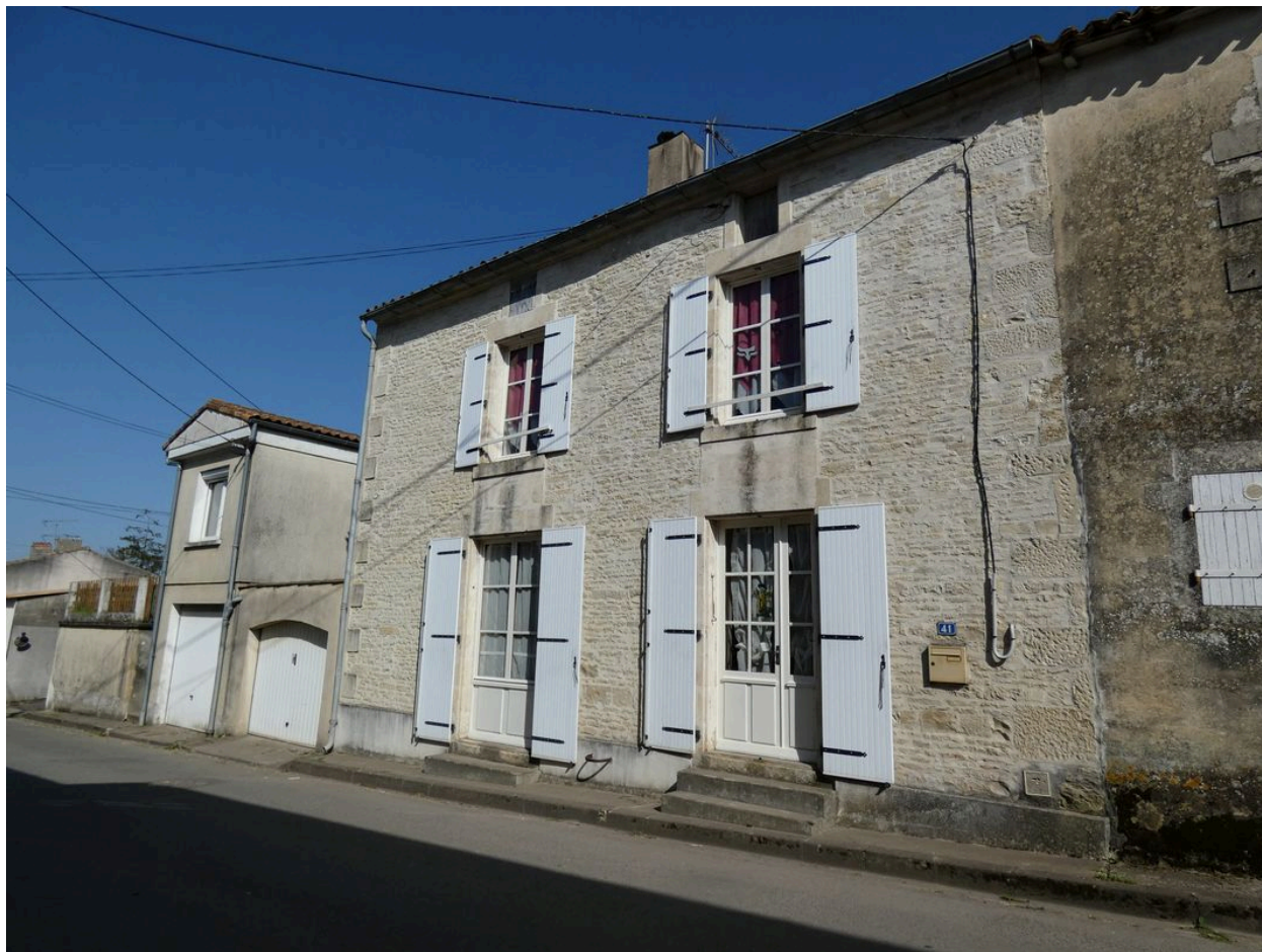
Vue depuis le sud-ouest.
