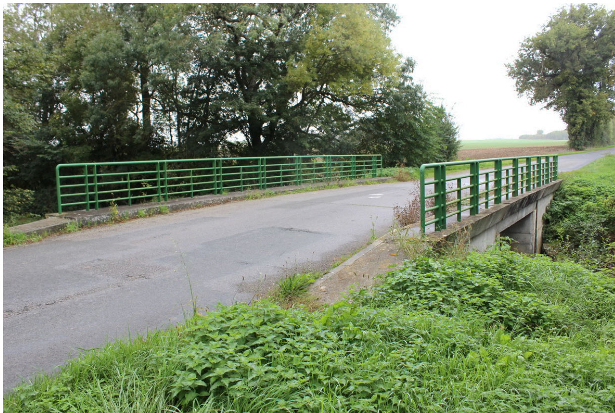
Une vue du Pont Rouge, depuis le sud-est.
