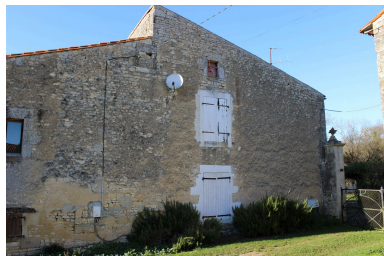
Le logement. Phot. Pierrick Barreau IVR54_20161710542NUCA
