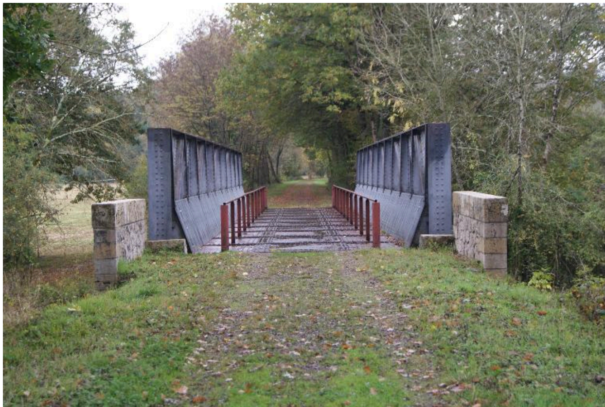
Vue du pont de fer sur le Gabas depuis le nord.
