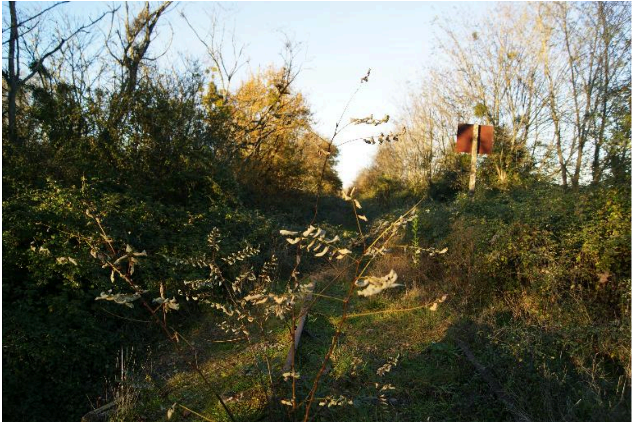
Vue de la voie ferrée vers le nord depuis le pont cage de l'Adour.
