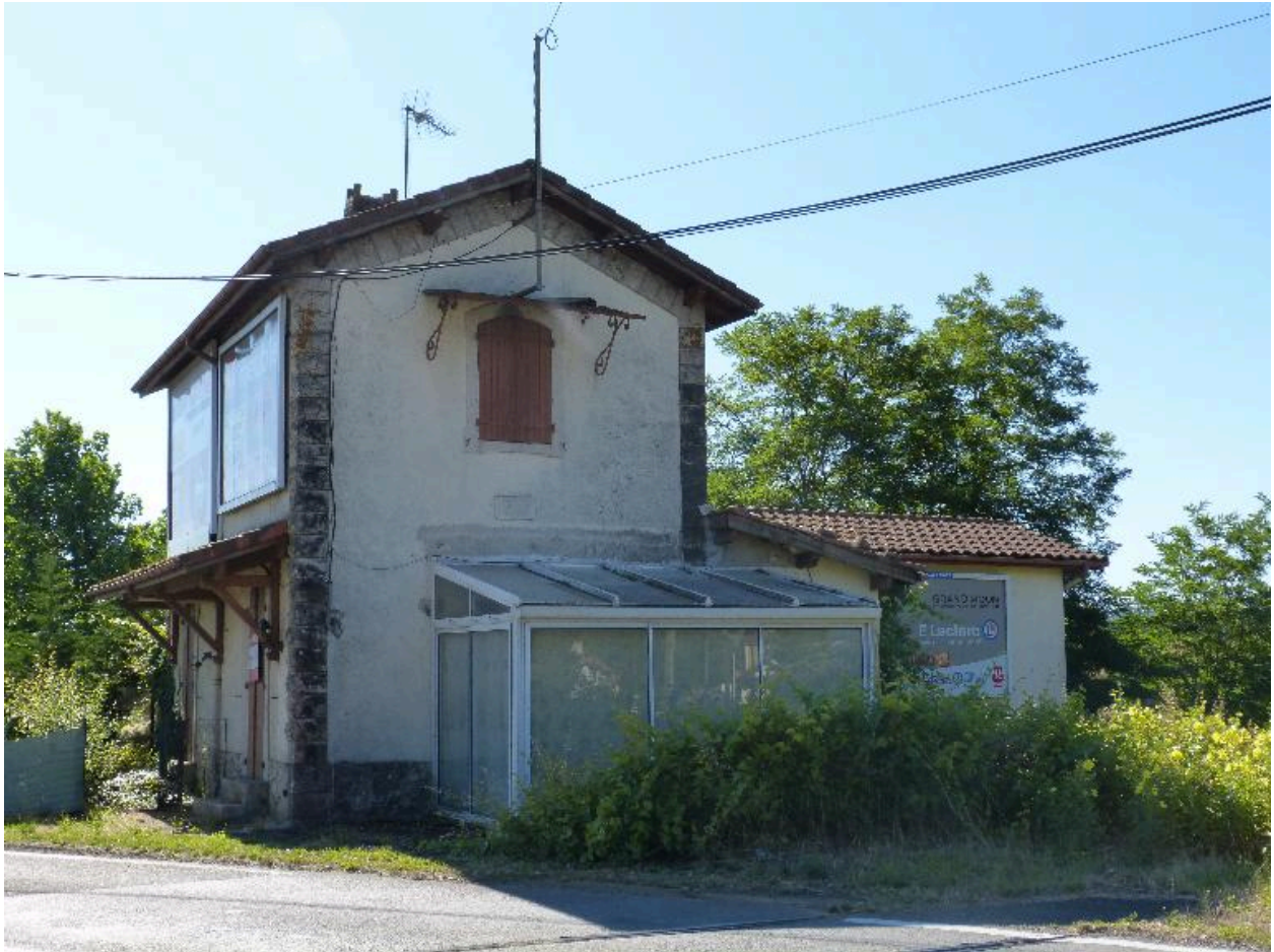
Vue de la maison du garde-barrière sur la route de l'Armagnac.
