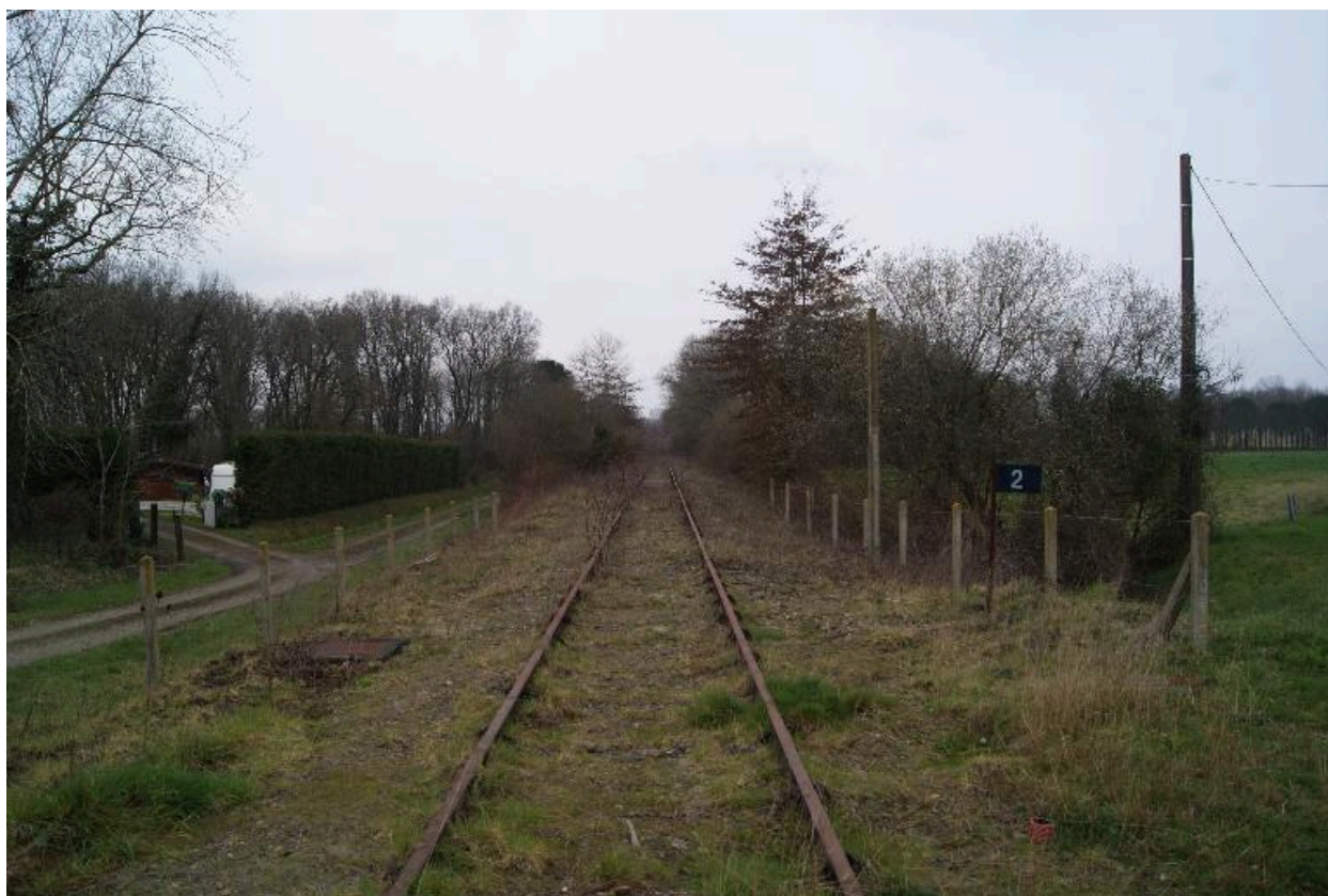
Vue de la voie ferrée vers Banos.
