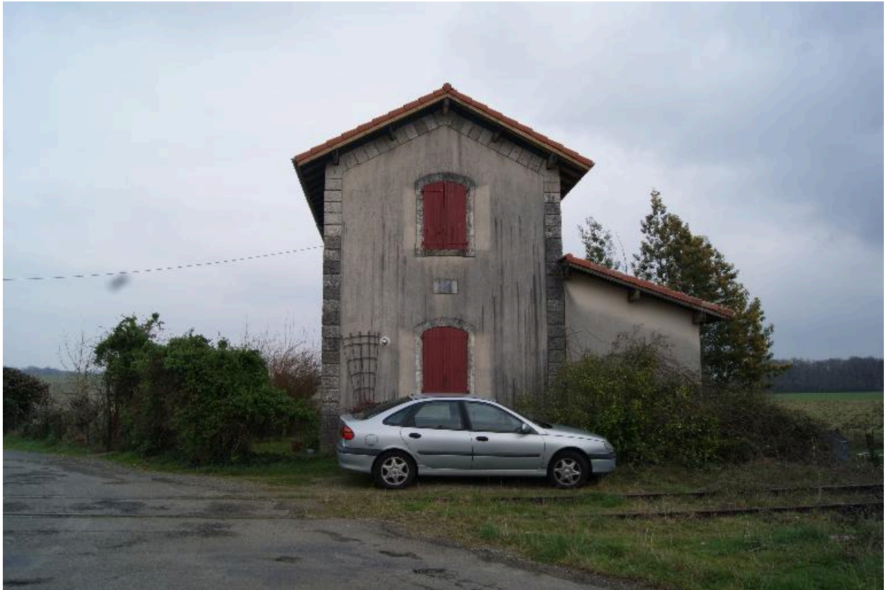
Vue de la maison du garde-barrière vers Banos.
