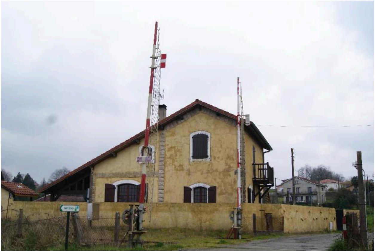
Vue de la maison du garde-barrière d'Augreuilh.
