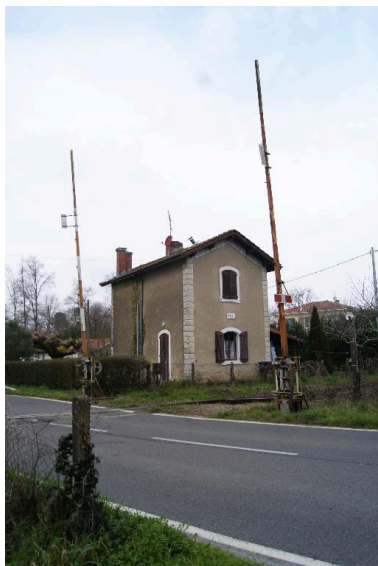
Vue de la maison du garde-barrière à l'ouest d'Augreuilh. Phot. Marie Ferey IVR72_20164000318NUC2A
