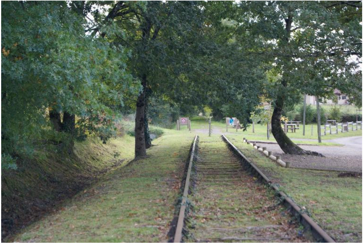
Vue de la voie ferrée vers l'ouest depuis la halte d'Augreuilh.
