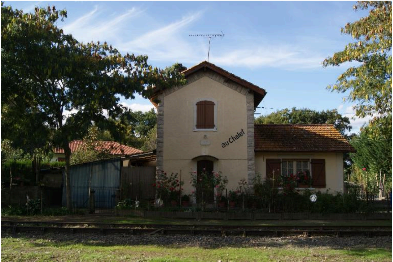
Vue de la maison du garde-barrière à la halte d'Augreuilh.
