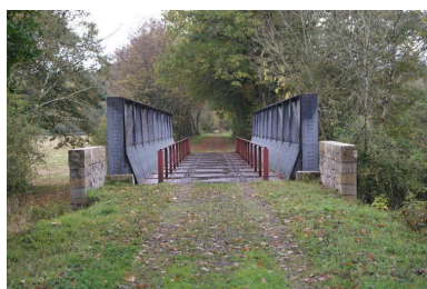
Vue du pont de fer sur le Gabas depuis le nord. Phot. Marie Ferey IVR72_20164000305NUC2A
