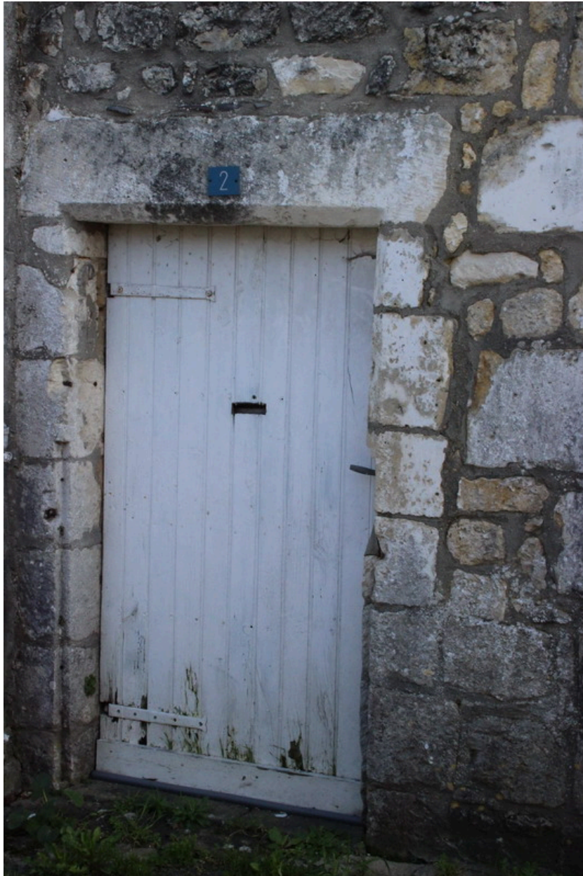
Un détail de la porte de la maison, depuis le nord-ouest.
