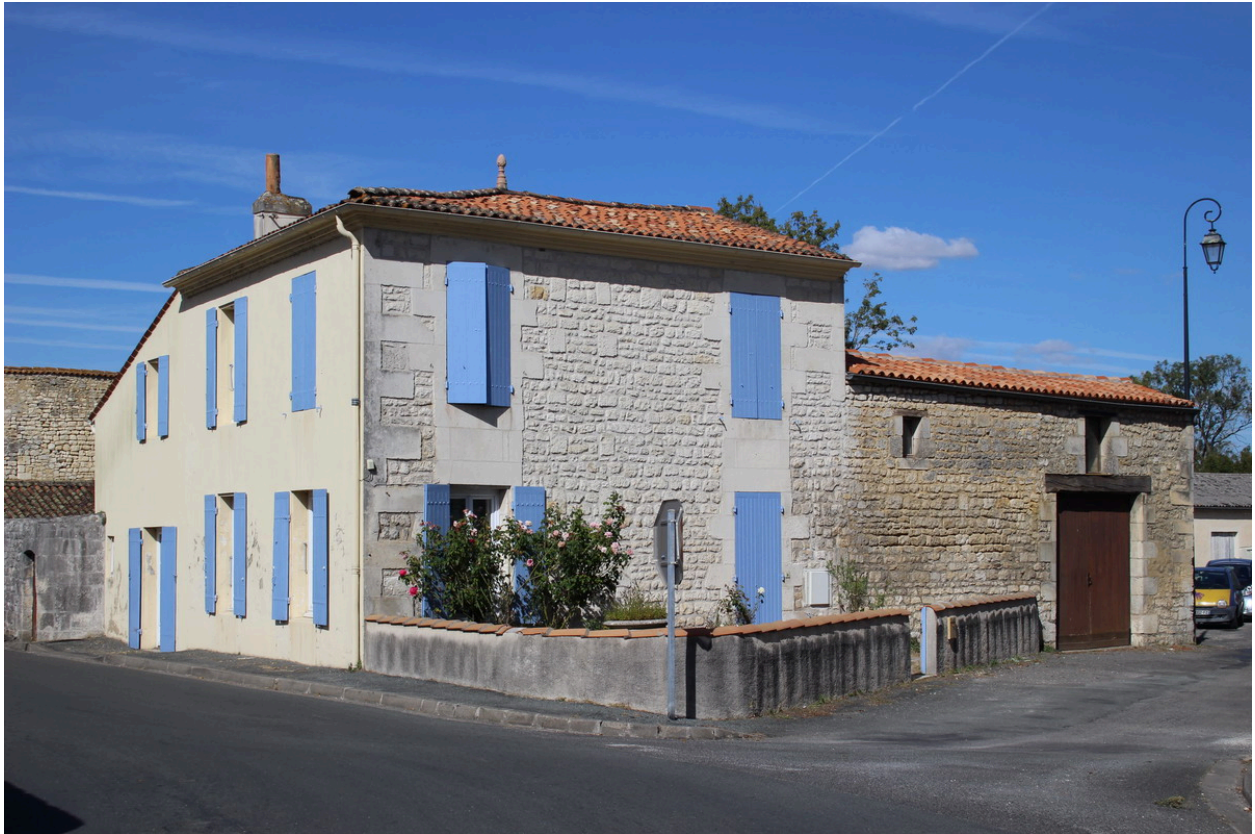
Une vue d'ensemble de la maison et des dépendances accolées et adossées, depuis le sud-ouest.
