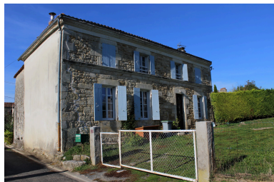
Une vue de la première maison, depuis le sud-est. Phot. Nathalie Lhuissier IVR54_20171711489NUCA
