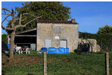
Une vue de la deuxième maison, depuis le sud-ouest. Phot. Nathalie Lhuissier IVR54_20171711490NUCA
