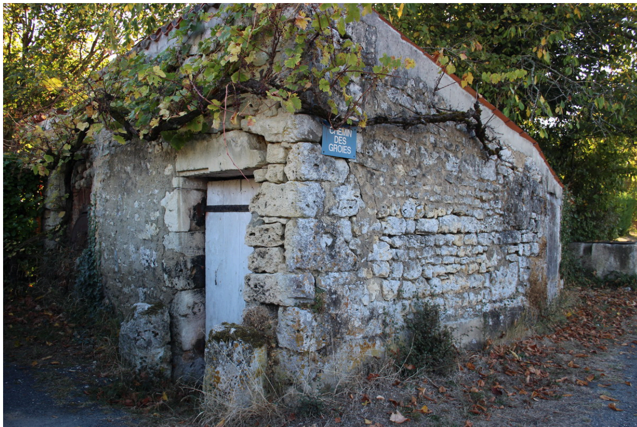
Une vue des dépendances, depuis le nord-ouest.
