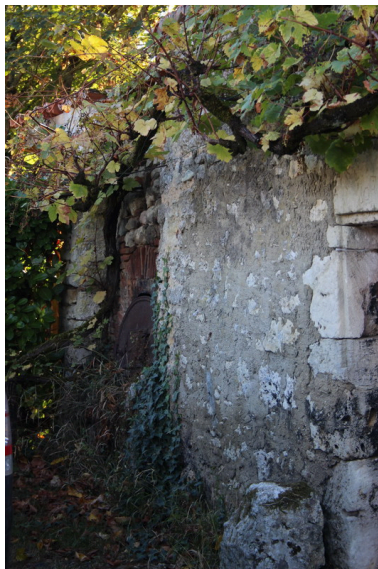
Une vue du four, depuis le nord-ouest. Phot. Nathalie Lhuissier IVR75_20181702869NUCA
