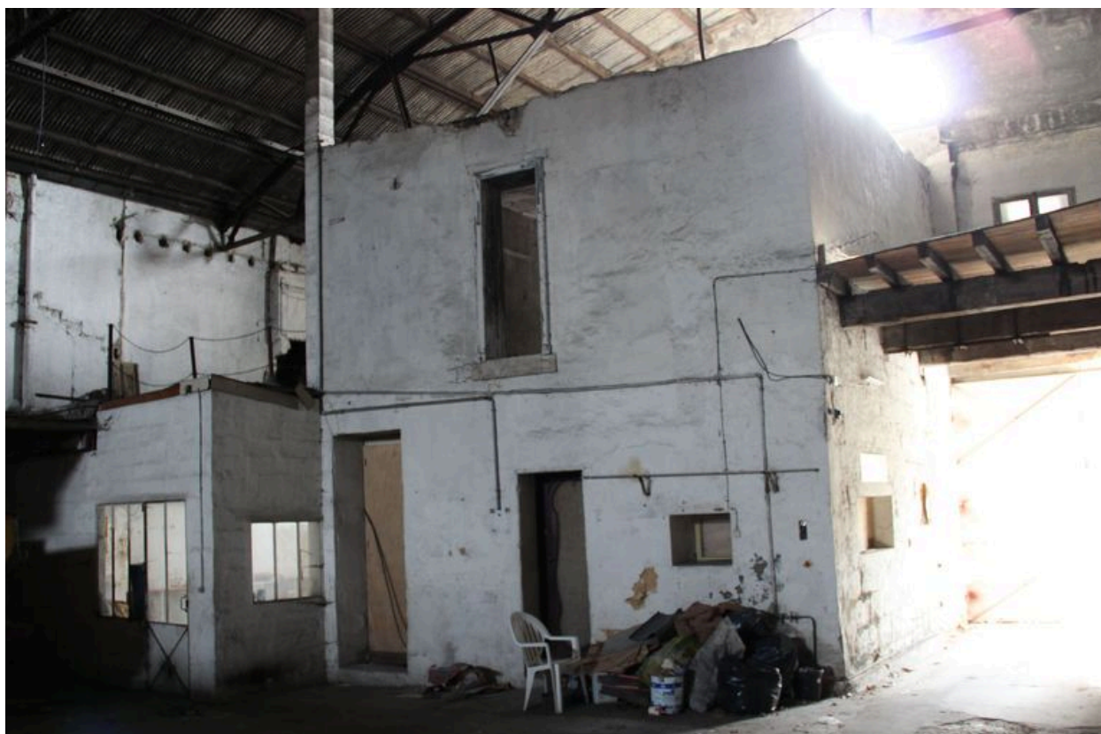
Vue intérieure : ancien bureau.
