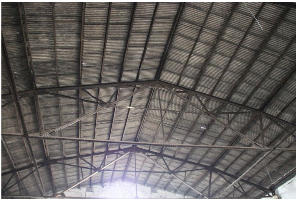
Vue intérieure : charpente métallique.
