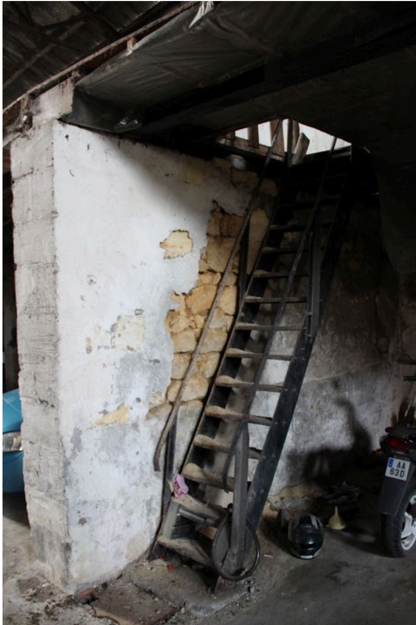
Vue intérieure : escalier permettant d'accéder au niveau de stockage.
