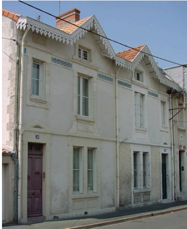
Vue générale. Phot. Claire Peyron IVR54_20041704519NUCA
