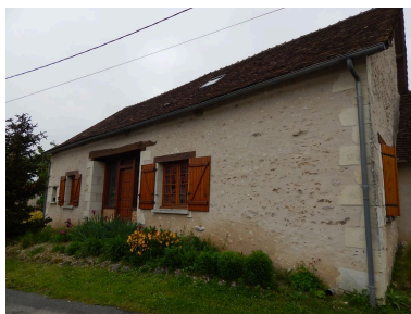
Élévation nord-ouest. Phot. Paul Maturi IVR75_20198606004NUCA
