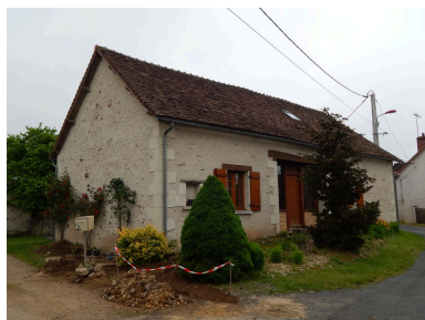
Élévation nord-ouest. Phot. Paul Maturi IVR75_20198606000NUCA
