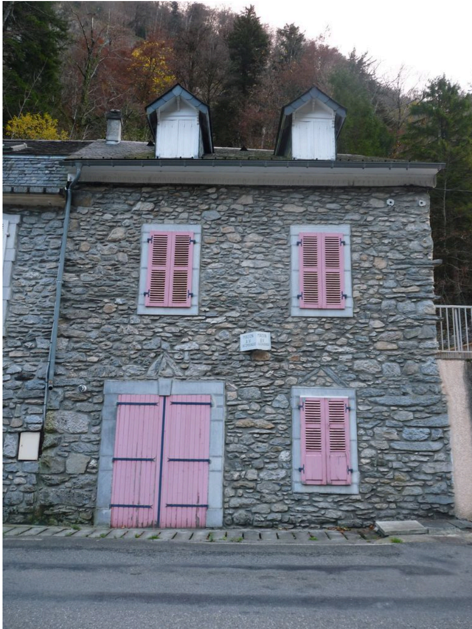
Façade principale de la partie droite.
