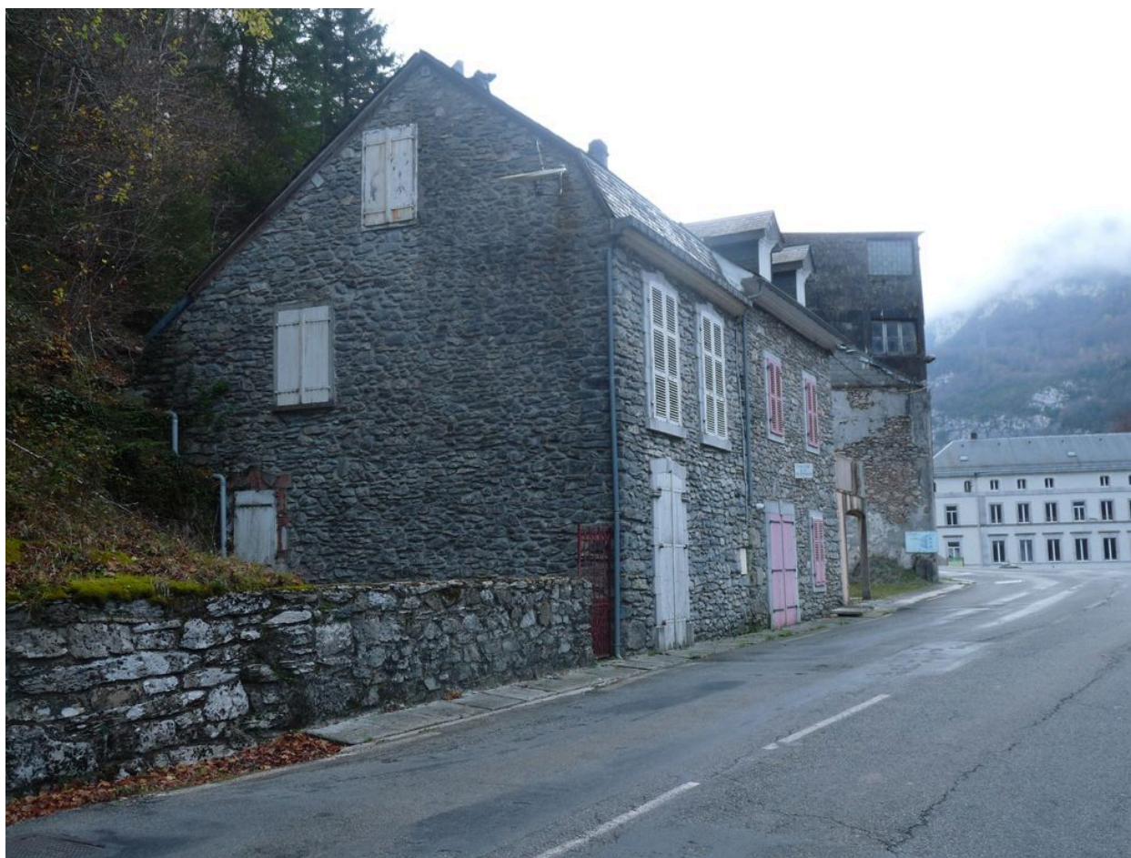
Vue d'ensemble et élévation latérale.
