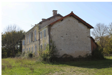
Une autre vue de la scierie, depuis le nord-est. Phot. Nathalie Lhuissier IVR54_20171701476NUCA
