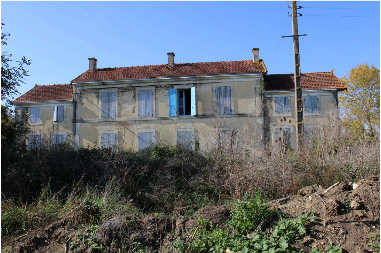
Une vue de l'ancienne scierie, depuis le sud-est.
