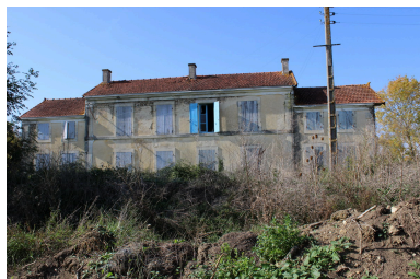
Une vue de l'ancienne scierie, depuis le sud-est. IVR54_20171701475NUCA
