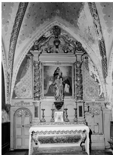
Vue d'ensemble (en 1969). Phot. Bernard Chabot, Phot. Michel Dubau IVR72_19694000460V
