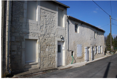
Une vue de la maison, au premier plan, depuis le sud. Phot. Nathalie Lhuissier IVR75_20181702667NUCA
