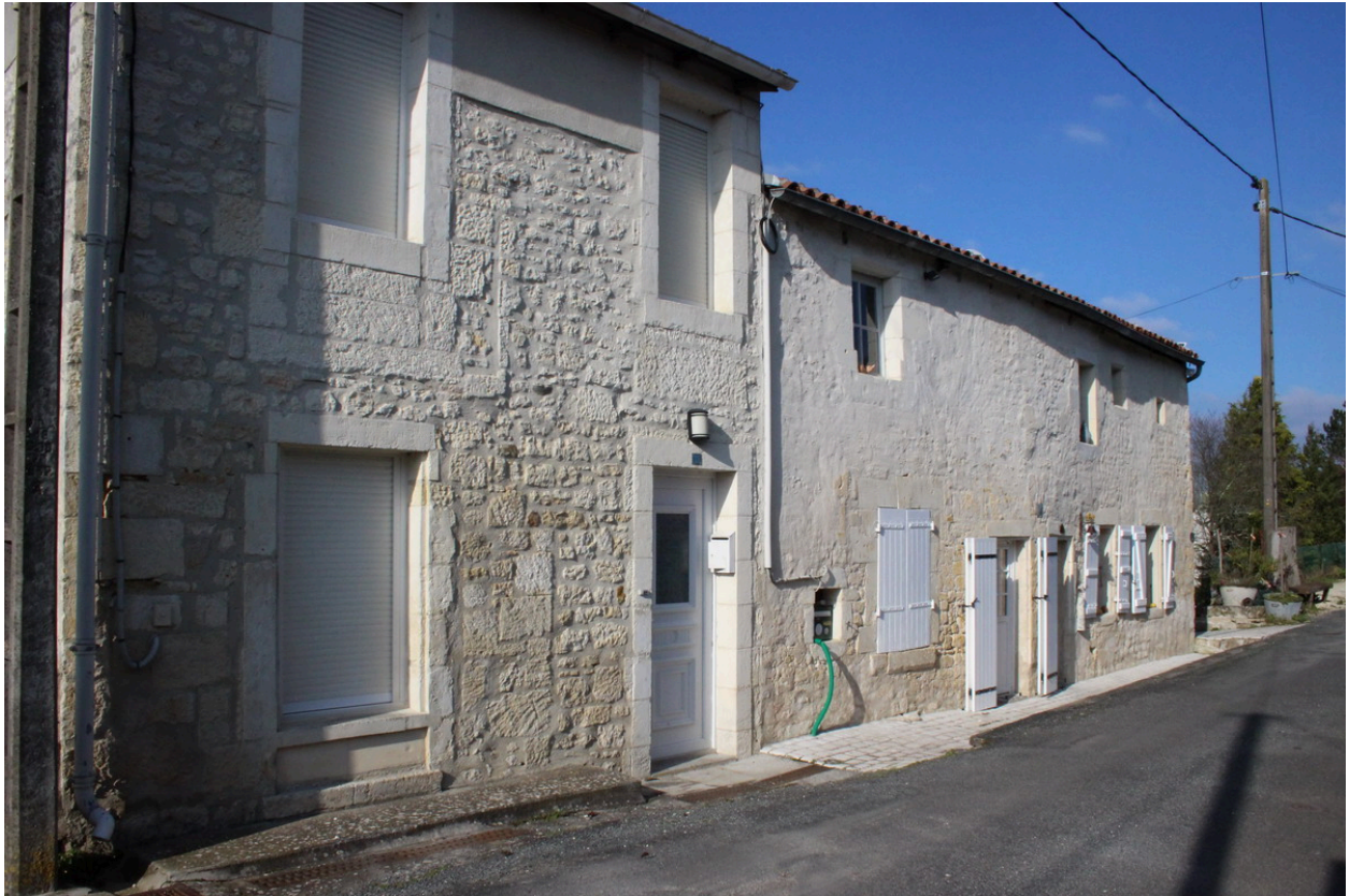
Une vue de la maison, au premier plan, depuis le sud.
