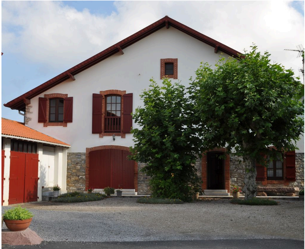
Vue de la façade principale depuis la cour.
