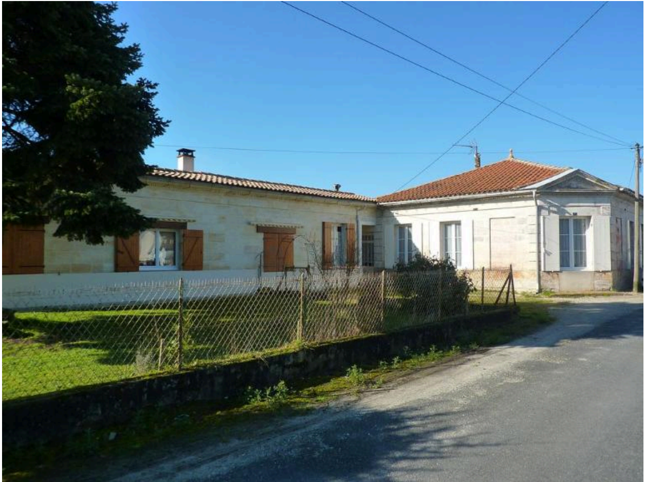
Maison au nord : façade donnant sur la rue de l'Eglise (parcelle 3041).
