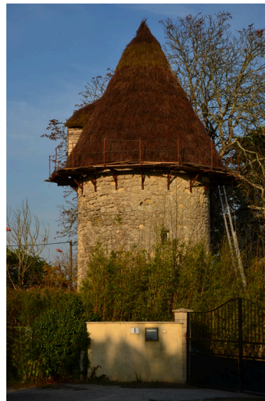
Moulin des Trois-Moulins. Phot. Florian Grollimund IVR72_20143306788NUC2A
