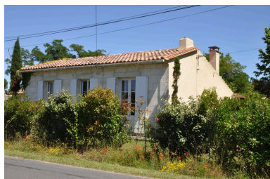
Vue d'ensemble. Phot. Jennifer Riberolle IVR72_20123302745NUCA
