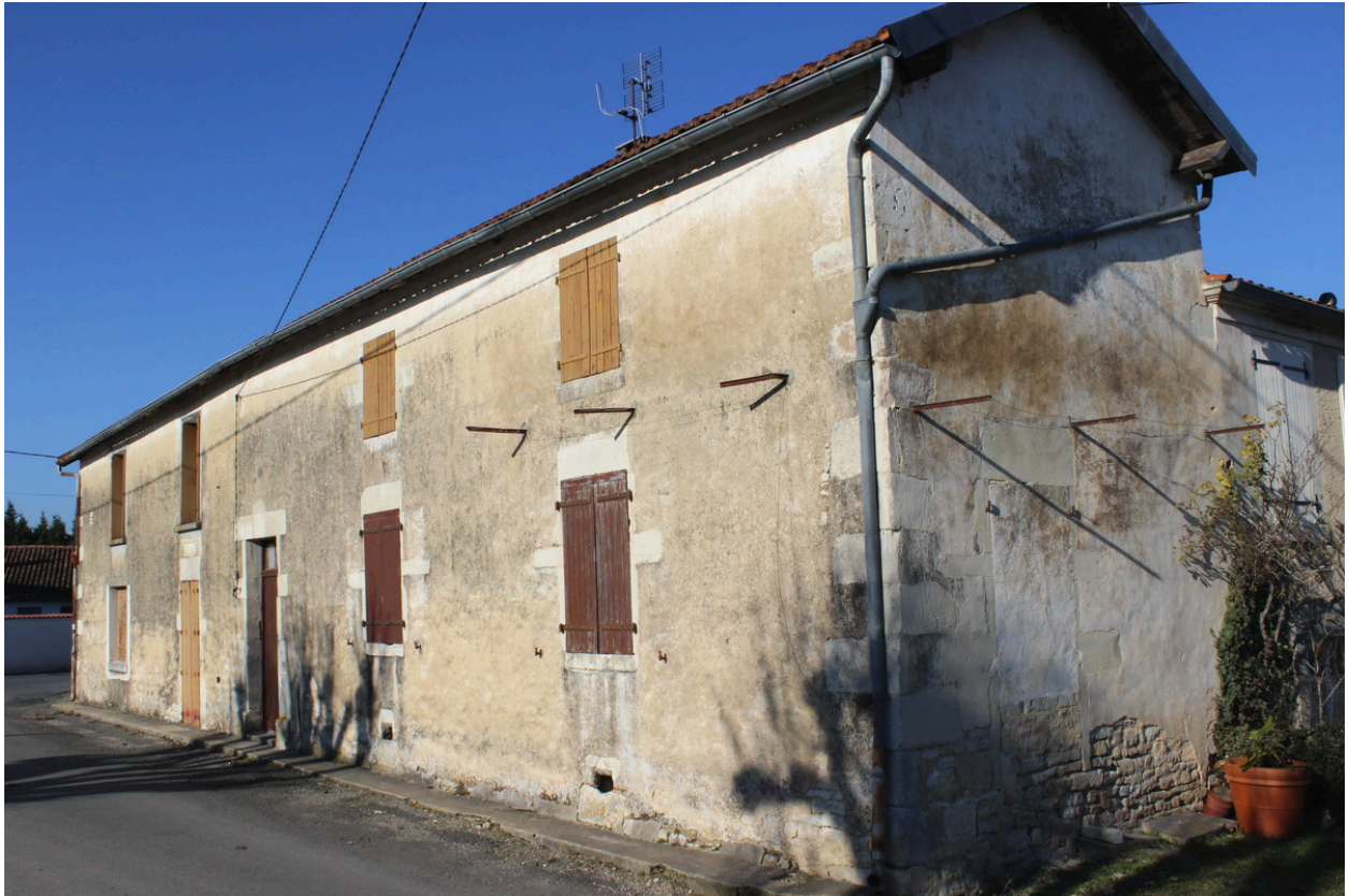
Une autre vue de la maison, depuis le sud-est.
