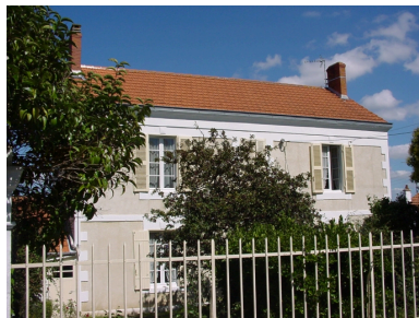
Vue générale. Phot. Claire Peyron IVR54_20041705835NUCA
