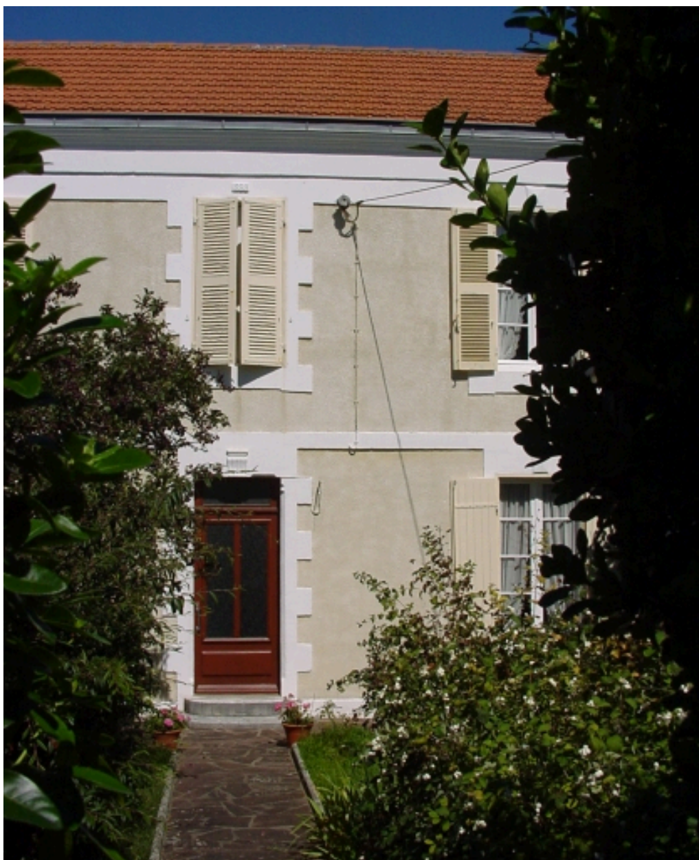
Façade, détail de deux travées.
