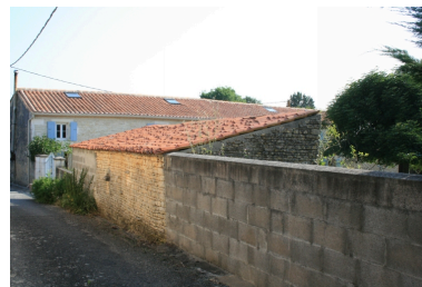
La dépendance à toit à un pan, depuis le sud-ouest.
