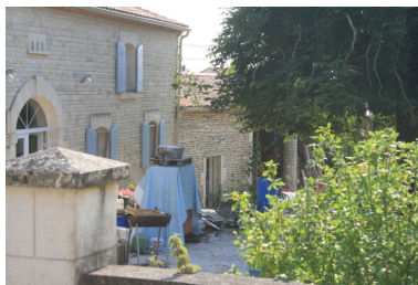
Les dépendances accolées, depuis l'ouest.
