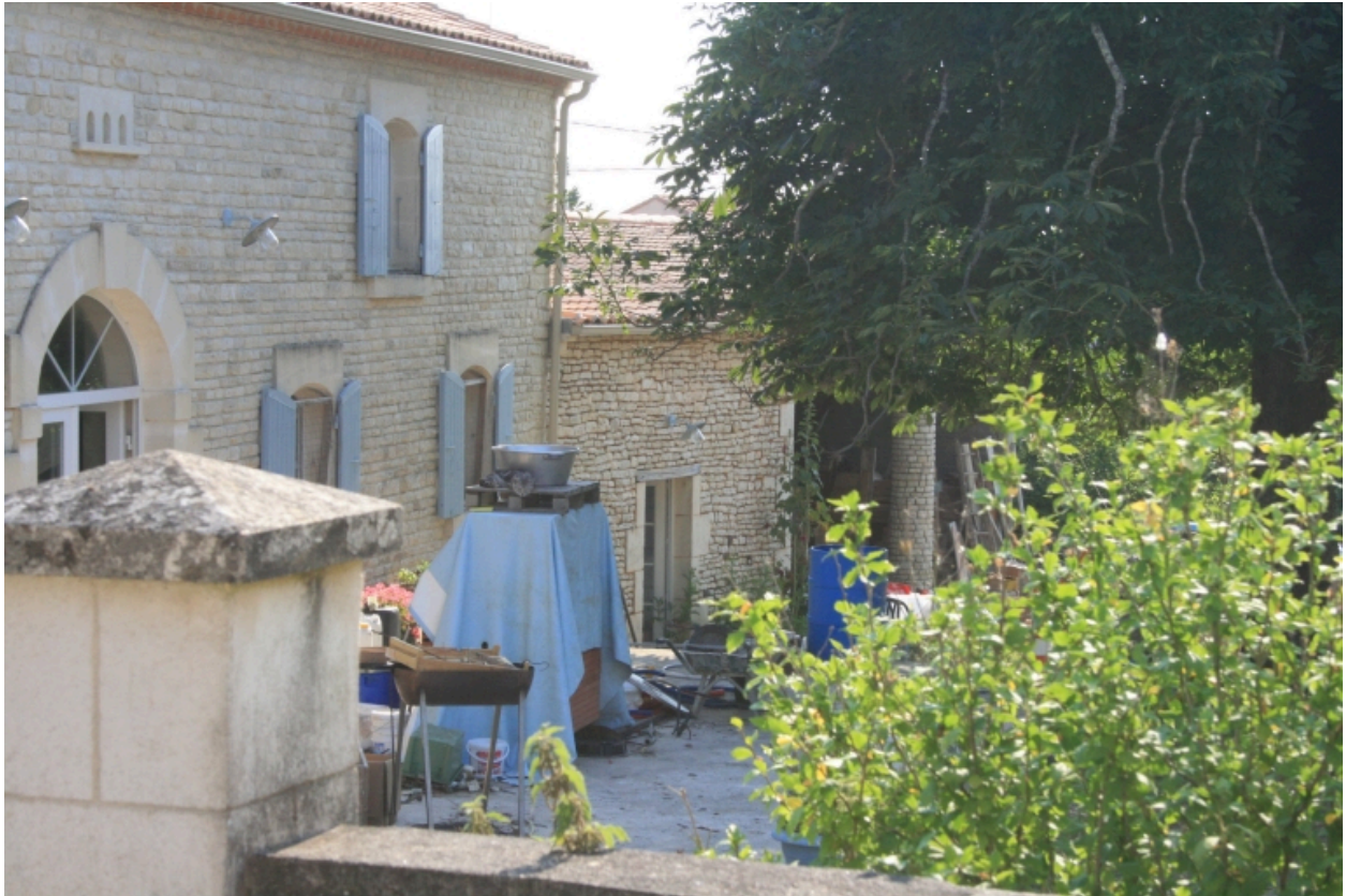
Les dépendances accolées, depuis l'ouest.
