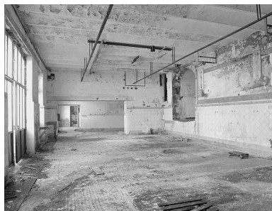
Intérieur de la beurrerie : vue prise vers l'est. Phot. Raphaël Jean IVR54_20027900730X
