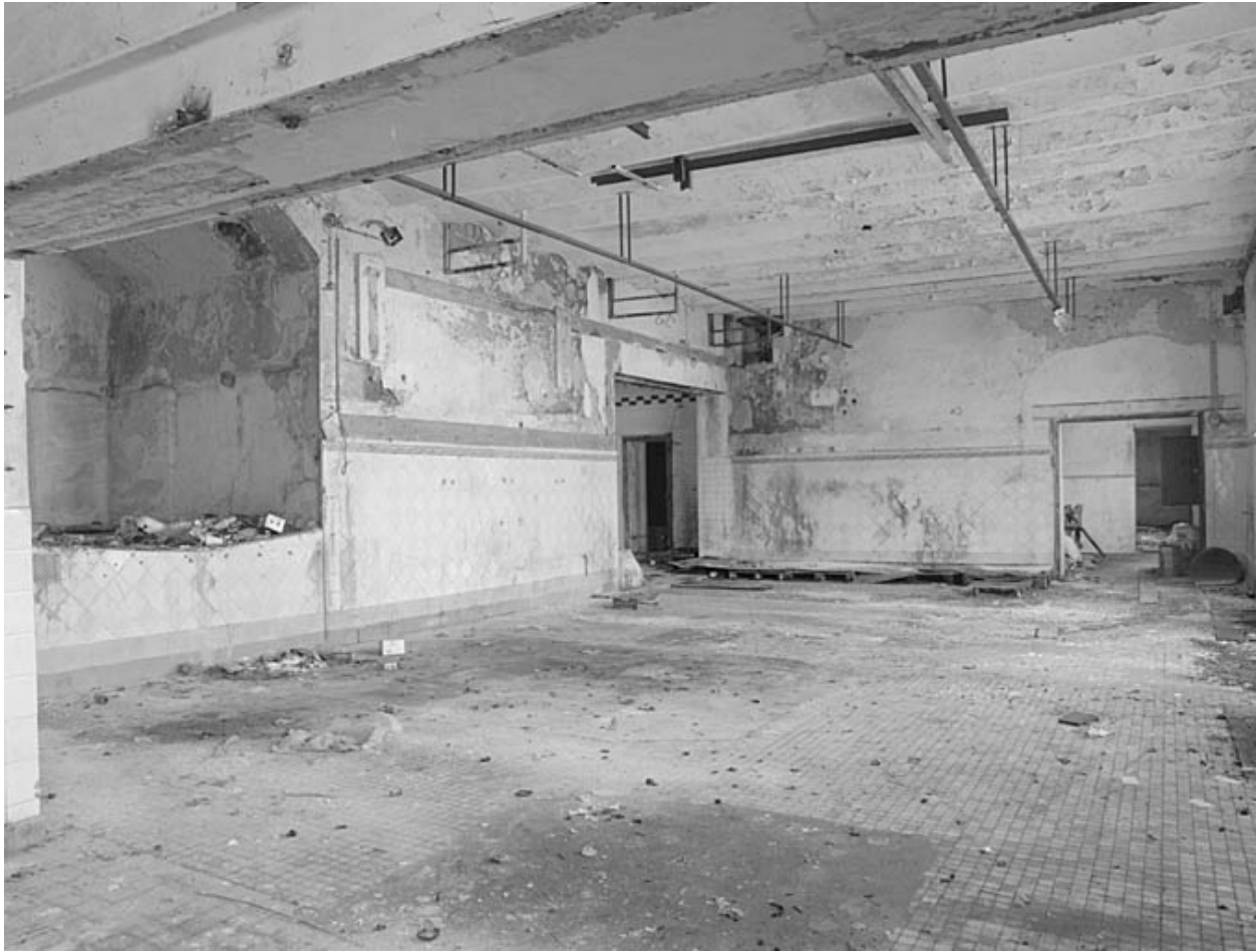
Intérieur de la beurrerie : vue prise vers l'ouest.
