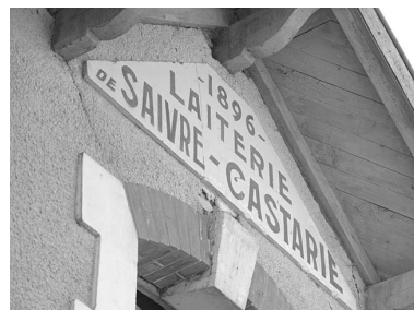
Détail de l'inscription du fronton du bâtiment primitif. Phot. Raphaël Jean IVR54_20027900727X
