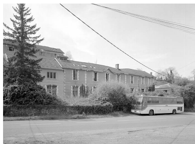
Vue du bâtiment principal prise de l'est. Phot. Raphaël Jean IVR54_20027900726V
