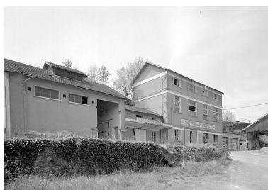
Atelier de fabrication de la poudre de lait et chaufferie vus de l'est Phot. Raphaël Jean IVR54_20027900728V
