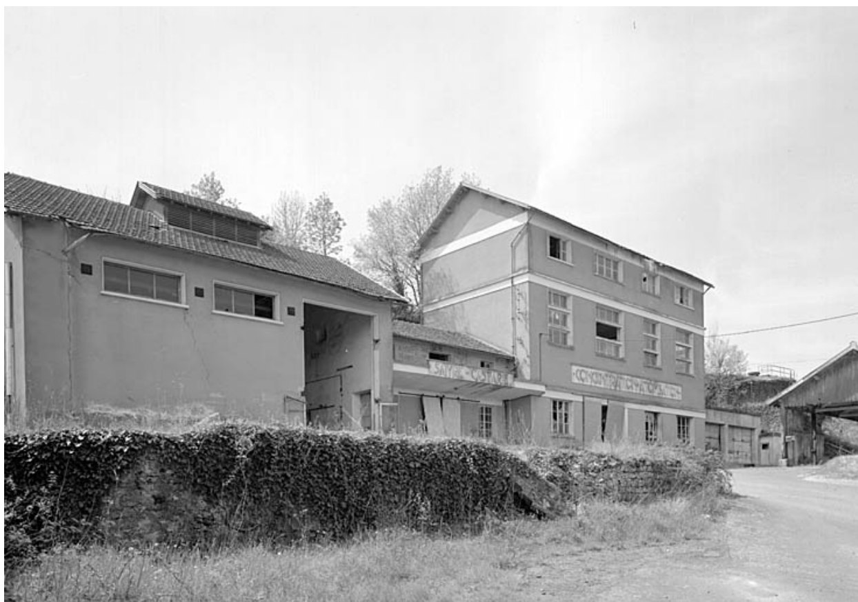
Atelier de fabrication de la poudre de lait et chaufferie vus de l'est
