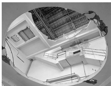
Intérieur de l'atelier de fabrication de la poudre de lait : vue de l'emplacement de la tour Spray. Phot. Raphaël Jean IVR54_20027900733X
