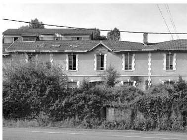
Partie centrale de l'élévation antérieure du bâtiment principal. Phot. Alain Dagorn IVR54_20027900820V
