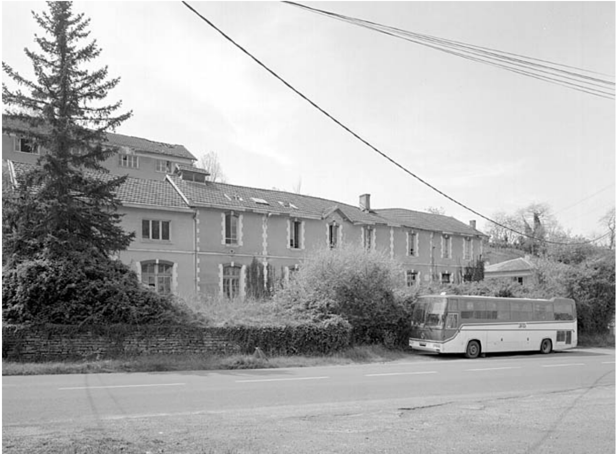
Vue du bâtiment principal prise de l'est.
