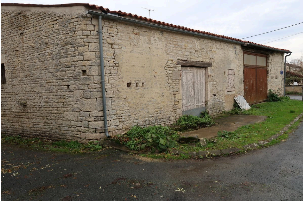
Vue de la grange étable située au nord.
