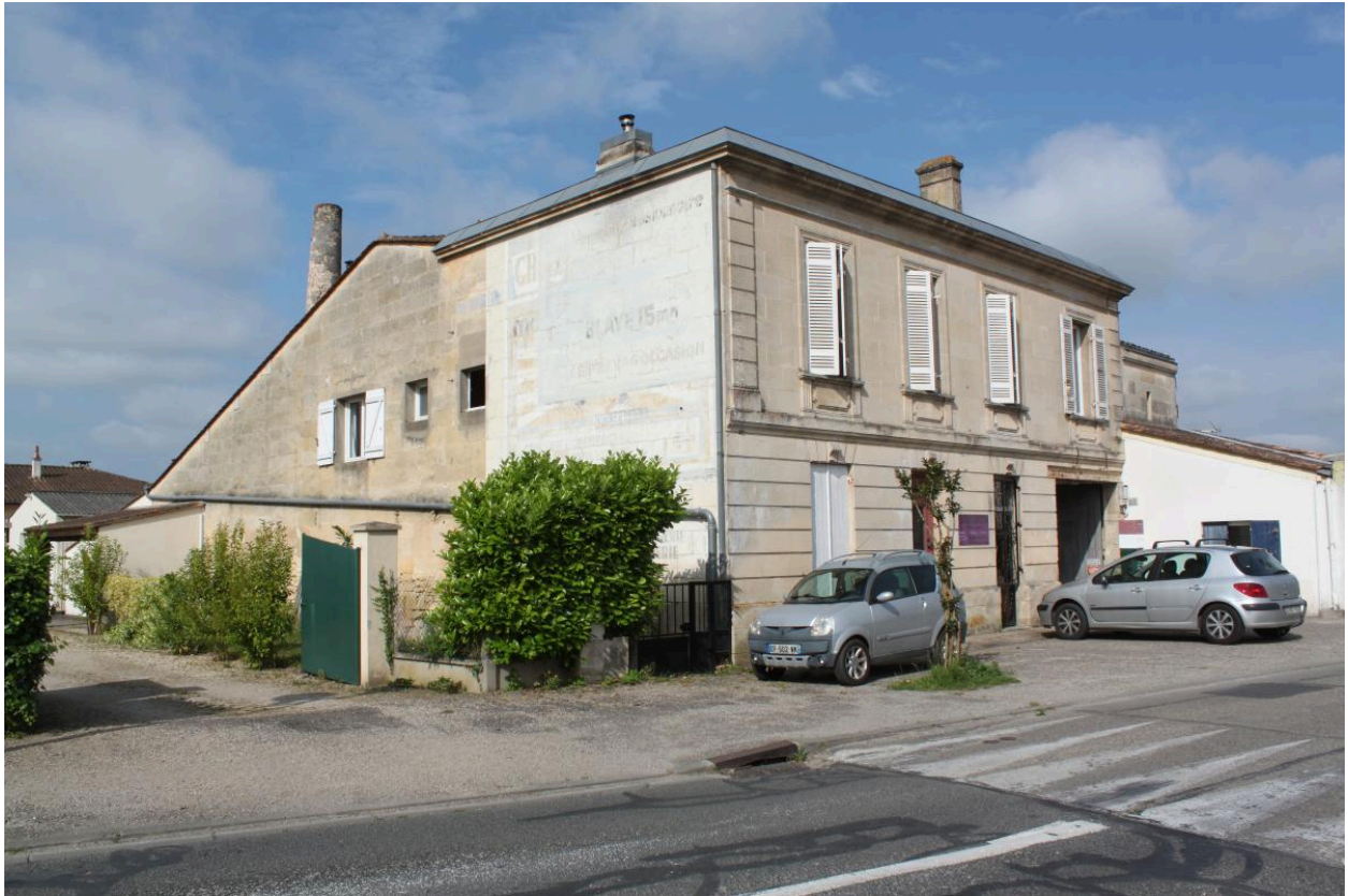
Vue d'ensemble avec cheminée en brique.
