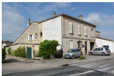
Vue d'ensemble avec cheminée en brique. Phot. Claire Steimer IVR72_20213300452NUC2A
