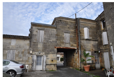
Élévation postérieure, vue depuis le sud-ouest. Phot. Jennifer Riberolle IVR72_20183302405NUC2A
