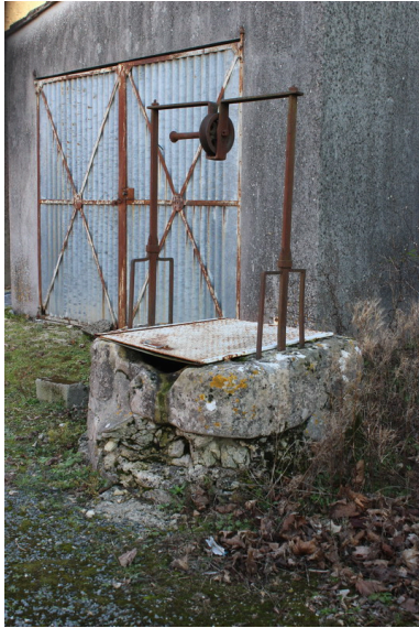
Une vue du puits, depuis le nord-ouest. Phot. Nathalie Lhuissier IVR54_20171700380NUCA
