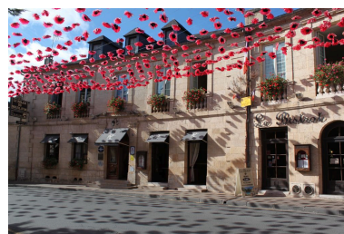
Elévation sur rue (est). Phot. Ophélie Ferlier IVR72_20122401654NUC2A
