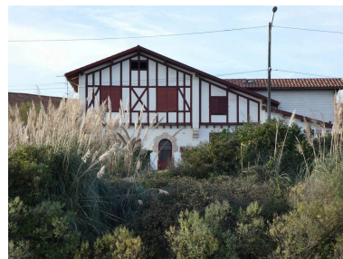
Vue de la façade principale de la station de tramway. Phot. Maïté Ehlinger IVR72_20196403074NUC2A
