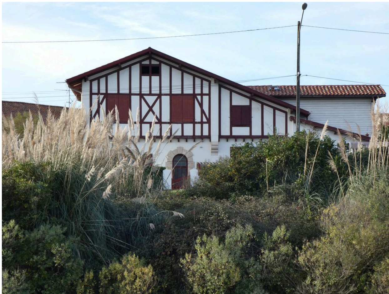
Vue de la façade principale de la station de tramway.
