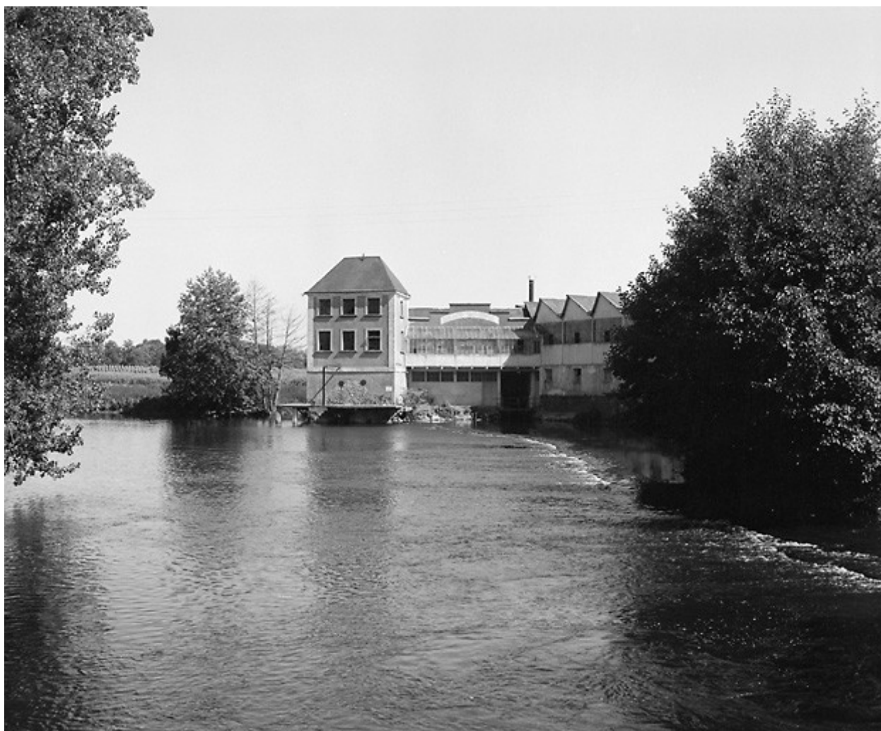
Le barrage de l'usine de construction mécanique Fenwick Linde S.A. à Bretagne, Cenon-sur-Vienne.
