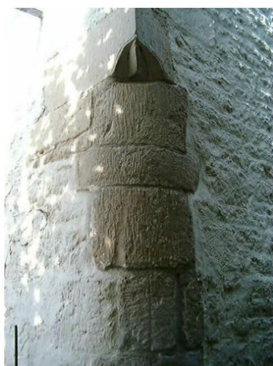
Eléments (chapiteau, blocs de colonne) provenant probablement de l'ancienne église, réemployés à l'angle est d'une maison dont la façade a été très remaniée. Phot. Charlotte Pon IVR54_20027901729NUCA
