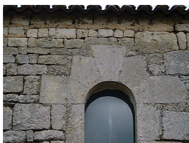
Eglise, élévation latérale droite, baie de droite, détail de l'appareil de l'arc. Phot. Charlotte Pon IVR54_20027900721NUCA
