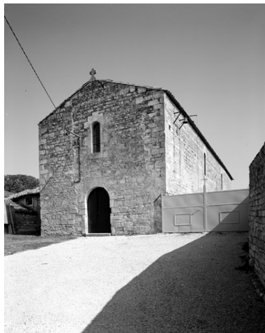
La façade occidentale. Phot. Alain Dagorn IVR54_19967900866V
