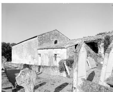
Les élévations sud et est et la sacristie. Phot. Alain Dagorn IVR54_19967900867V
