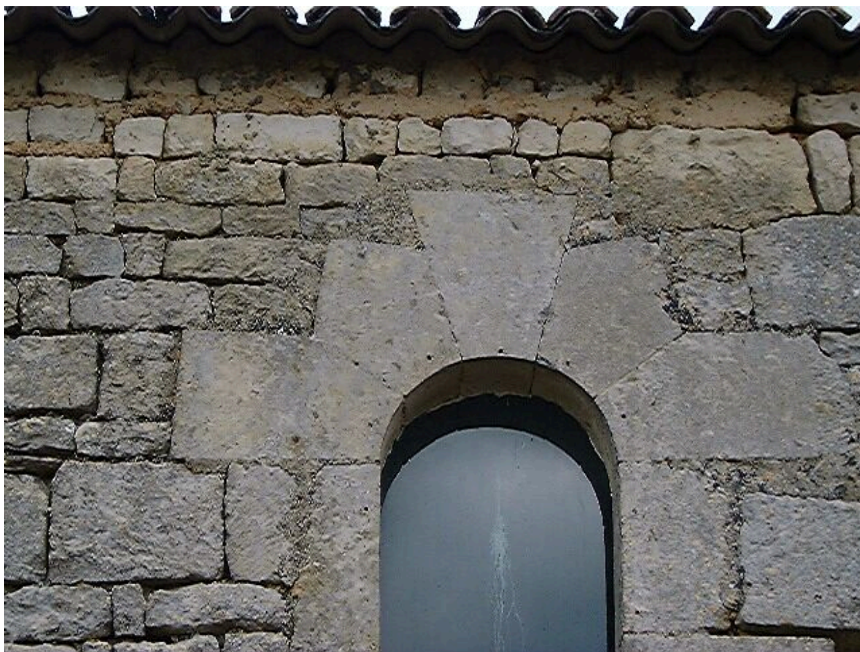
Eglise, élévation latérale droite, baie de droite, détail de l'appareil de l'arc.
