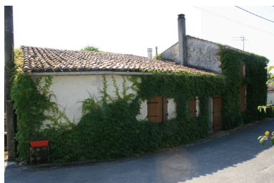
Le logement et l'ancienne dépendance accolée, depuis le nord-ouest.
