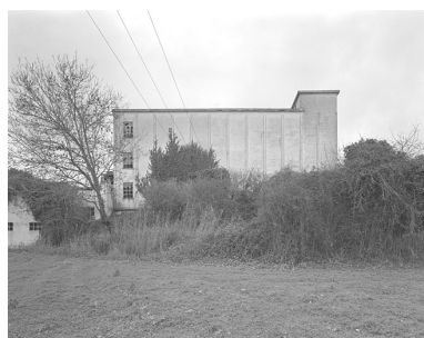
Vue prise de l'est. Phot. Marc Deneyer IVR54_19981700020V
