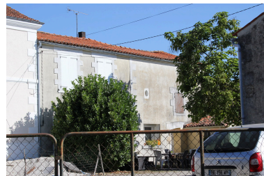
Une vue du deuxième logement de l'ancienne ferme et des dépendances accolées, depuis le sud-ouest.
