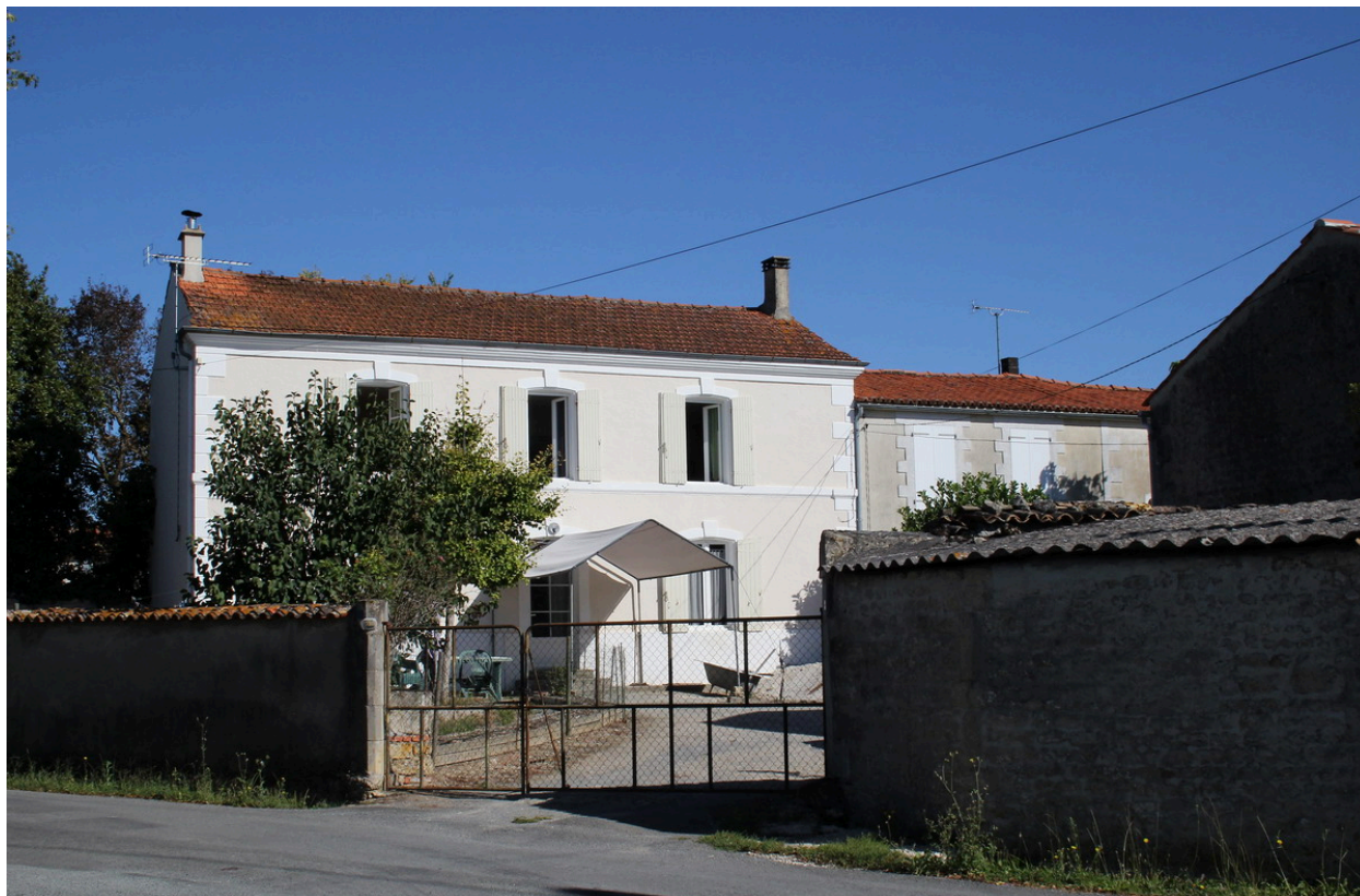
Une vue du premier logement de l'ancienne ferme, depuis le sud-ouest.
