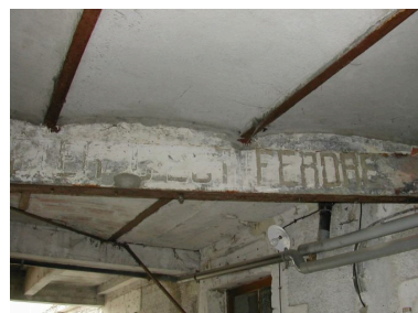
Détail du plafond à vouîtains de brique avec l'inscription Prêter c'est perdre. Phot. Pascale Moisdon IVR54_20047900096NUCA
