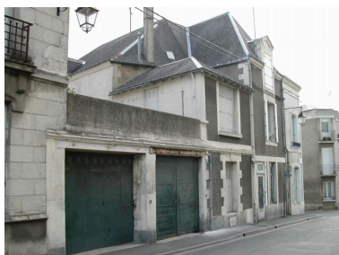
Elévation des bâtiments sur rue. Phot. Pascale Moisdon IVR54_20047900095NUCA
