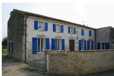
Une vue d'ensemble, depuis le sud-ouest. Phot. Pierrick Barreau IVR54_20131701290NUCA
