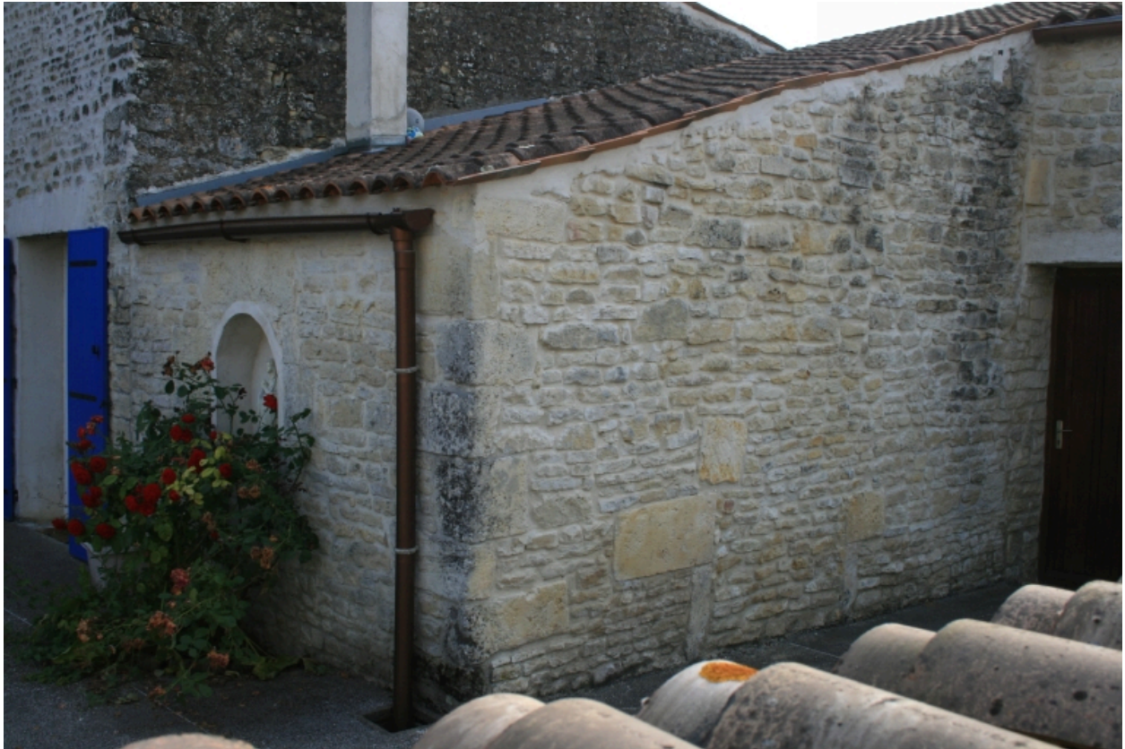
Une des dépendances, depuis le sud-ouest.
