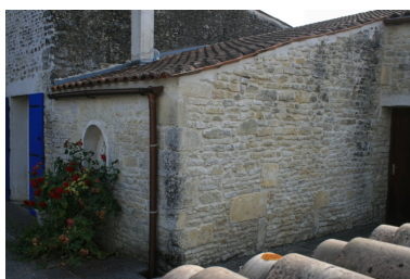
Une des dépendances, depuis le sud-ouest. Phot. Pierrick Barreau IVR54_20131701291NUCA
