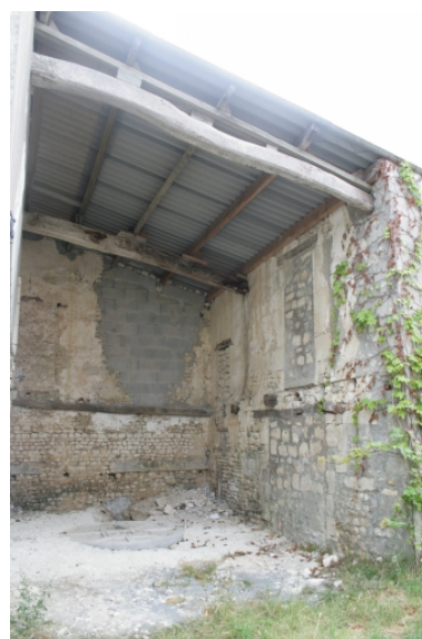
L'intérieur du hangar actuel, depuis le nord-est. Phot. Cécilia Guiberteau IVR54_20091701430NUCA
