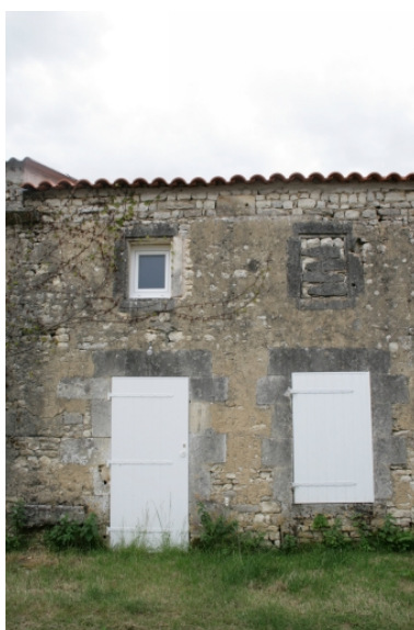
Le logement de la ferme, depuis le nord-ouest. Phot. Cécilia Guiberteau IVR54_20091701431NUCA
