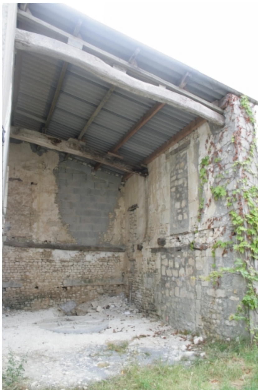
L'intérieur du hangar actuel, depuis le nord-est.
